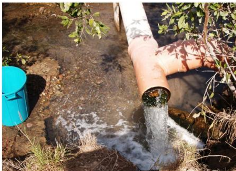
Figura 2. Tubo de descarga de agua de mar proveniente de la planta de cultivo de peces del CIAD. El contenedor que se observa a la izquierda del tubo fue el que se utilizó para medir el gasto.
