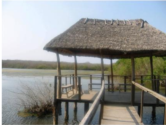
Figura 4. Plataforma de observación localizada en la laguna sur.
