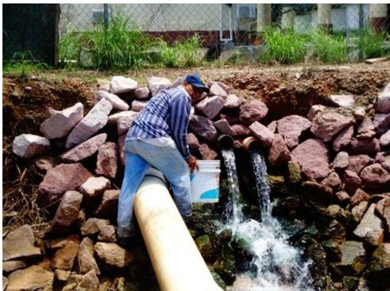
Figura 11. Ejemplificación de la medición del vertimiento de agua marina de la Planta piloto de peces marinos del CIAD hacia la laguna sur. Fuente de la fotografía: C. Peraza, agosto 2019.
