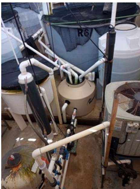
Figura 1. Sistema de recirculación de la unidad experimental para inducción a la reproducción de L. peru .
